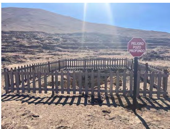
Pozo 5: cierre y peligro pozo profundo.
