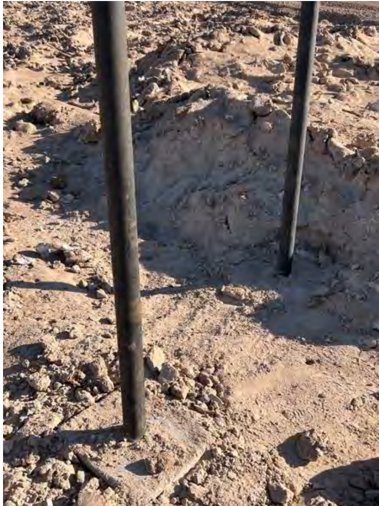
Fotografía 16: 08/07/2023. Instalación de carteles.
