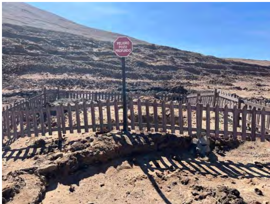
Pozo 7: cierre y peligro pozo profundo.
