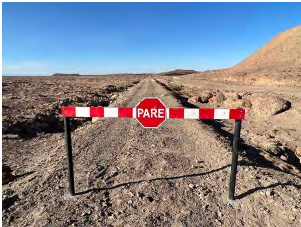
Fotografía 3: 08/07/2023. Barrera 1 en trocha ancha de tren.
