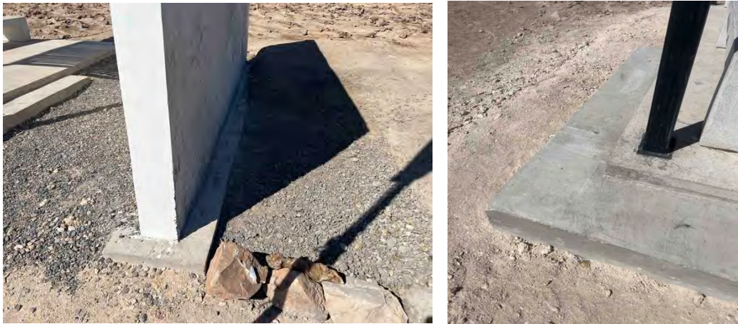
Fotografía 20: 09/07/2023. Detalles cemento del muro de hormigón armado y del piso radier.
