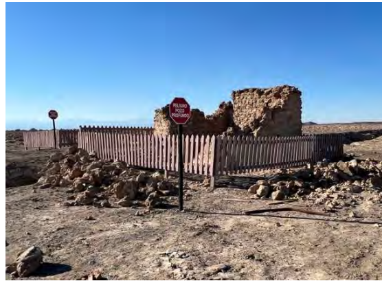
Pozo 2: cierre y peligro pozo profundo.
