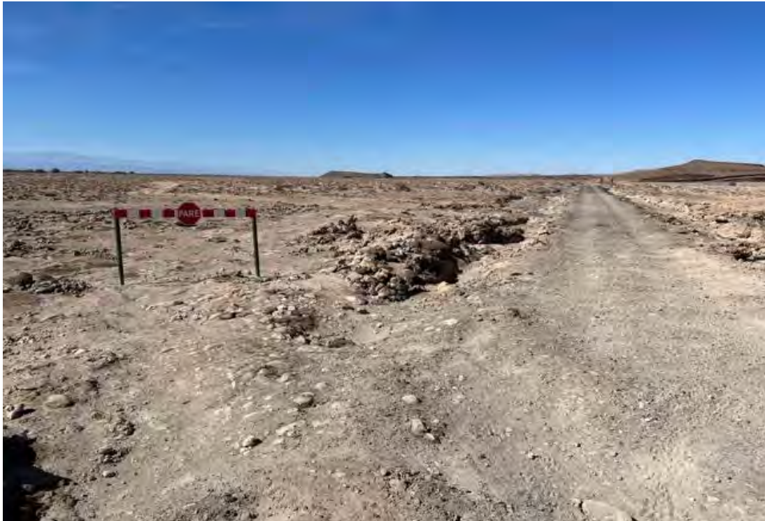
Fotografía 8: 08/07/2023. Barrera 6 en trocha ancha de tren.
