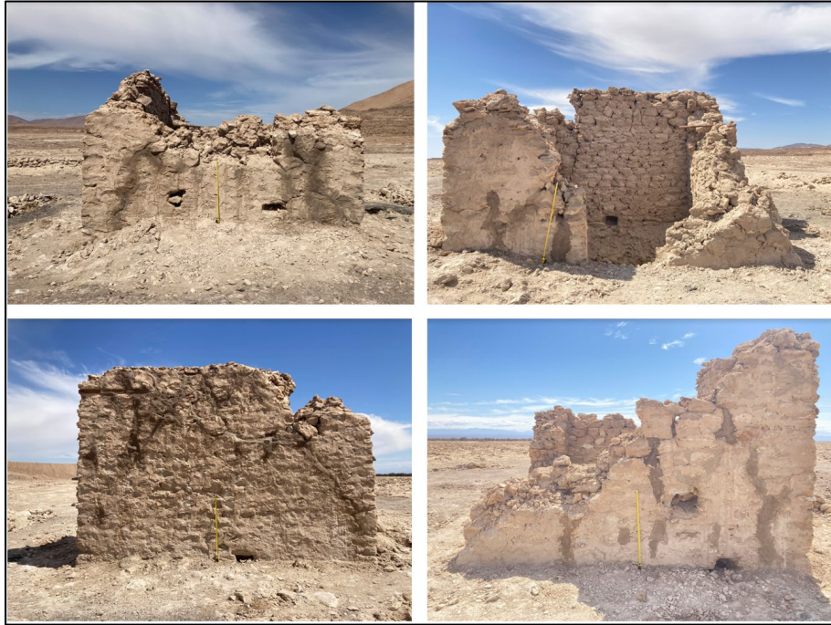
Resultados consolidación estructura 1
