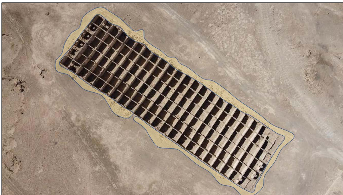
Figura 4. Área de la estructura 1 que se propone despejar.
