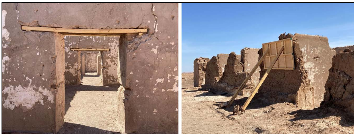
Fotografía 8: imágenes del proceso de estabilización estructura 2.
